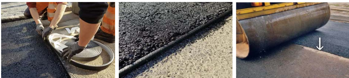
Рисунок 2 – Застосування самоклеючих бітумно-полімерних стиковальних стрічок Джерело: [1, 5]
