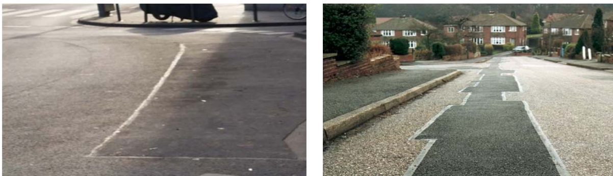
Рисунок 3 – Стан бітумно-полімерних стиковальних стрічок після тривалої експлуатації Джерело: [1, 5]
