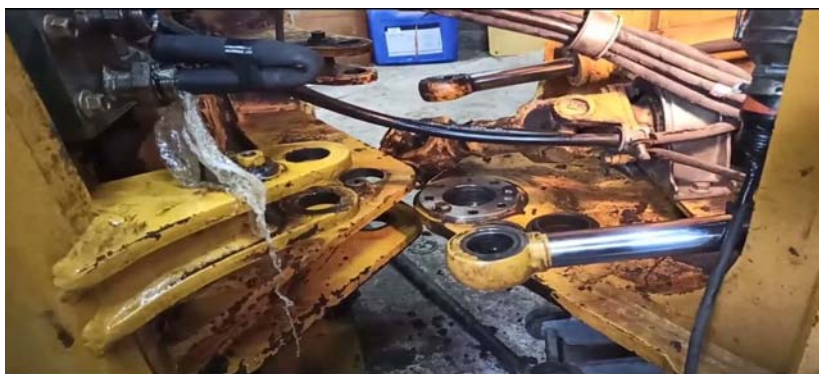
Рисунок 1 – Ремонт шарнірного з'єднання фронтального навантажувача
