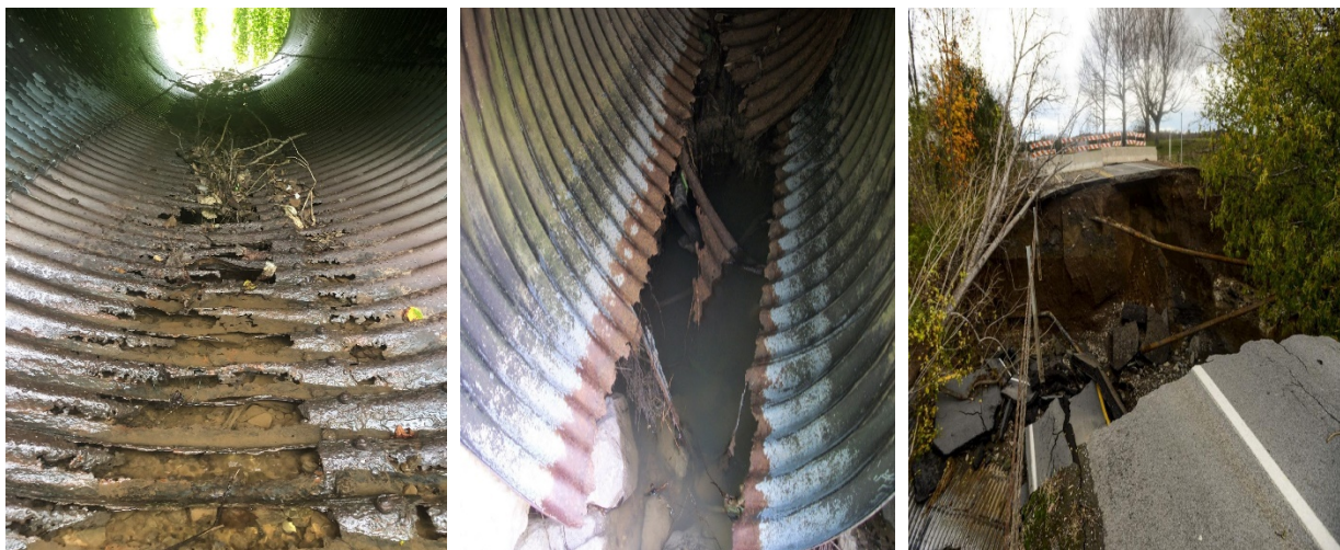
Рисунок 1 – Наслідки впливу корозії на дорожню водопропускну трубу з МГК Джерело: на підставі [5]
