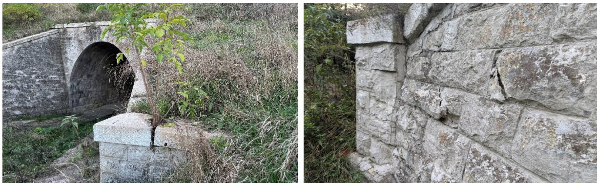
Рисунок 4 — Порость рослин, вихідний оголовок, руйнування кам'яних елементів
